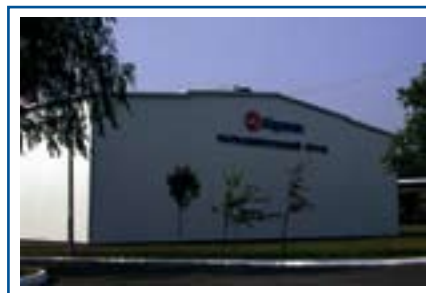
фармацевтический склад ОАО Химфармкомбинат «Акрихин», пос. Старая Купавна Московская обл. сентябрь 2000 – февраль 2001 2,5 тыс. м 2
